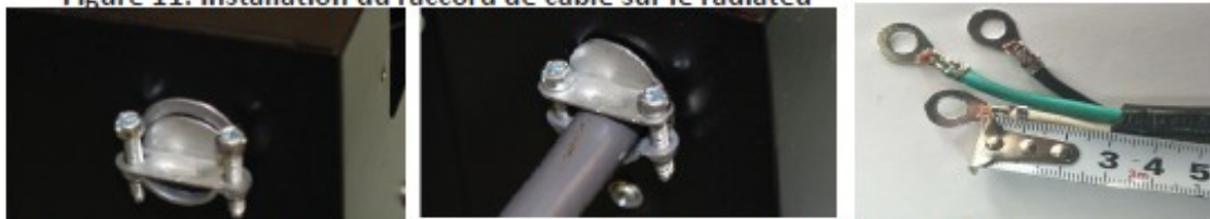
Figure 11: Installation du raccord de câble sur le radiateur
