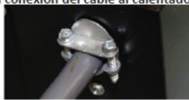
Figura 11: Instalación de la conexión del cable al calentador
